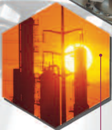
Generación de Electricidad
