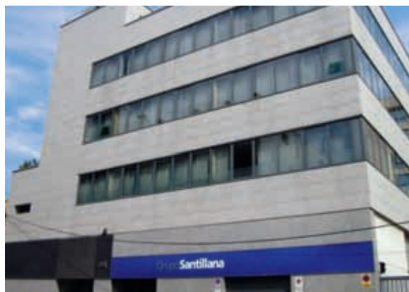
Editorial Santillana, Pinto (Madrid) Enfriadora aire-agua bomba de calor. Climatización oficinas.
