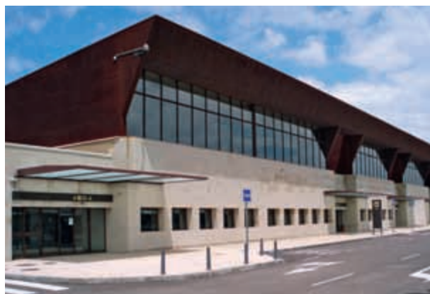
Aeropuerto de Salamanca, Salamanca Sistema de caudal variable. Climatización.
