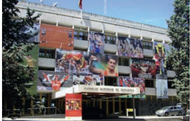
Consejo Superior de Deportes, Madrid Sistema de caudal variable. Climatización.
