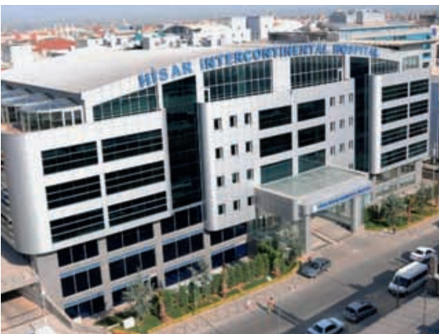
Hisar Hospital, Istanbul (Turkey) Sistema de caudal variable. Climatización.
