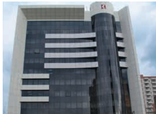
Capital Bank, Baku (Azerbaijan) Sistema de caudal variable. Climatización.
