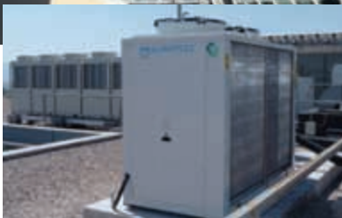
Facultad de Económicas, Murcia Enfriadora aire-agua bomba de calor, compresor scroll. Climatización.
